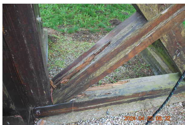
fot.6. Korozja elementów
