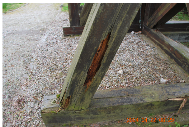
fot.4. Korozja elementów
