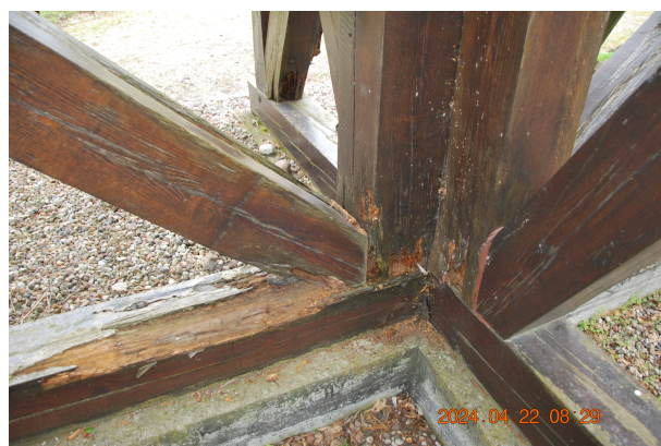
fot.3. Korozja elementów
