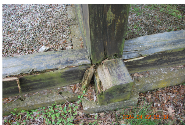
fot.7. Korozja elementów
