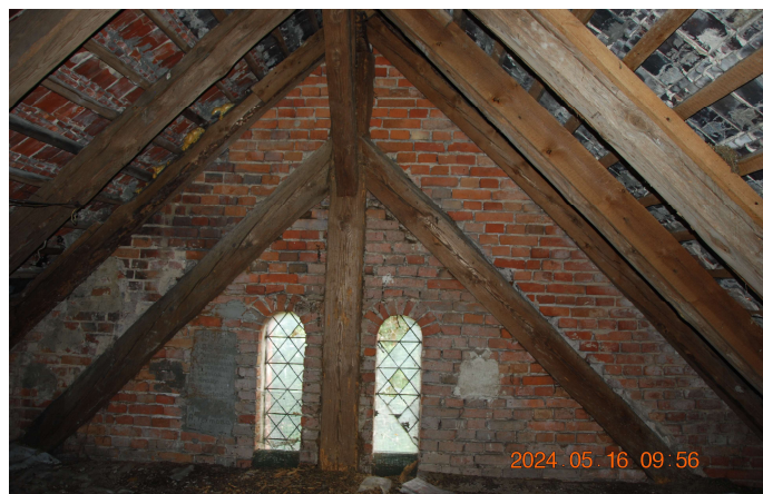
fot. 6. Widok konstrukcji wieszarowej w kierunku wschodnim
