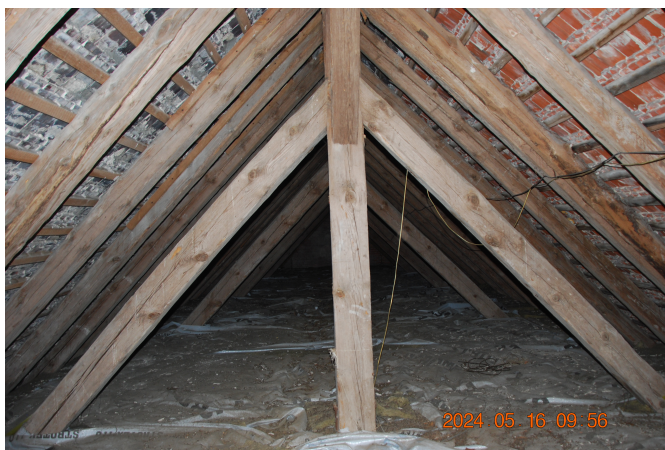
fot. 5. Widok konstrukcji wieszarowej w kierunku wschodnim
