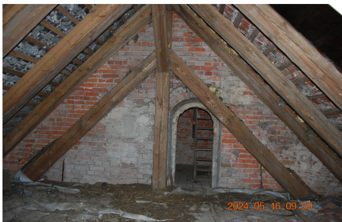
fot.4. Widok konstrukcji wieszarowej w kierunku zachodnim
