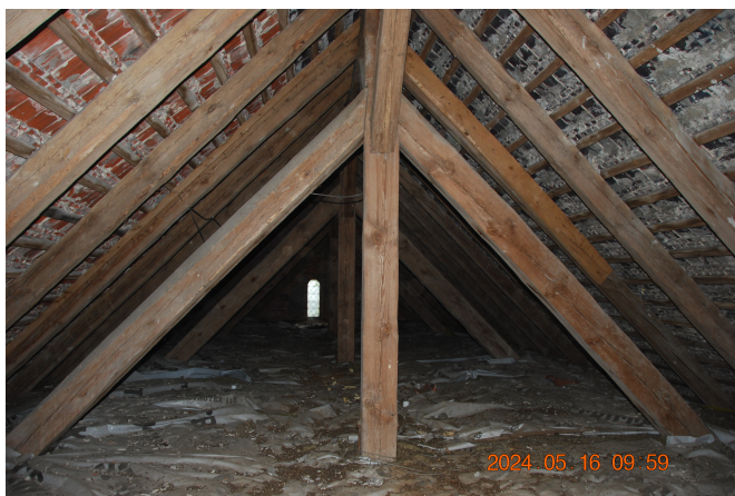
fot.3. Widok konstrukcji wieszarowej w kierunku zachodnim
